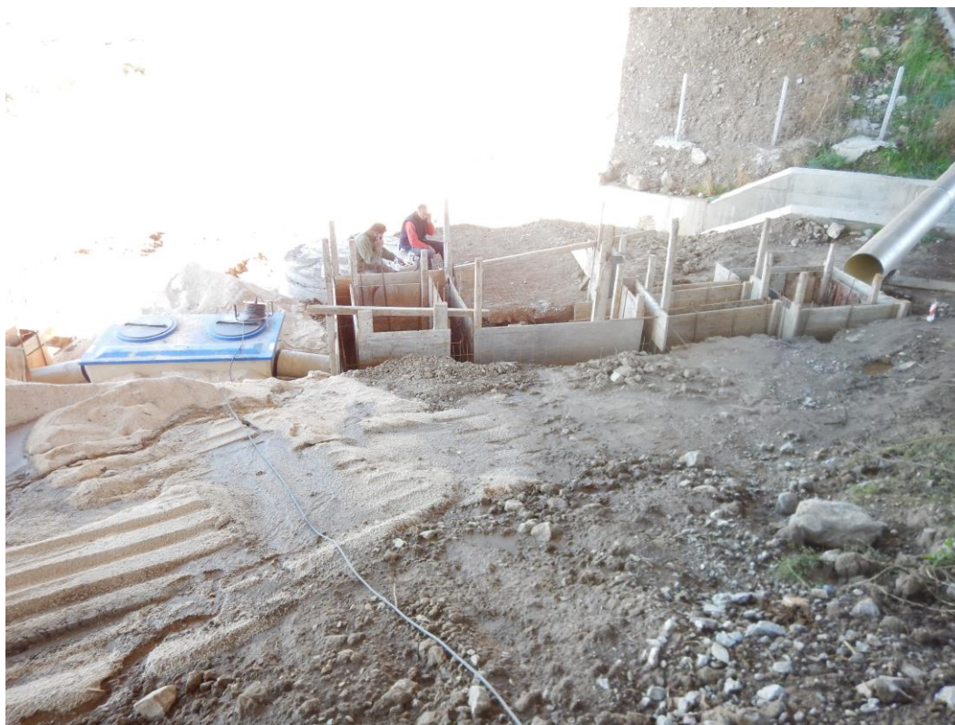
Γέφυρα π. Πηνειού. ΜΕΡ (ανάκτη).
