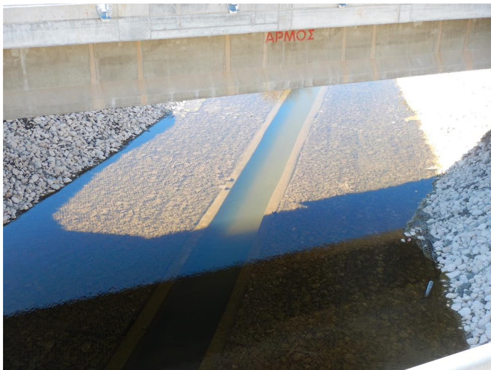
Γέφυρα διευθέτησης ρέματος. Χ.Θ. 39+400 για την εξυπηρέτηση των αμφίβιων και ιχθυοπανίδας.
