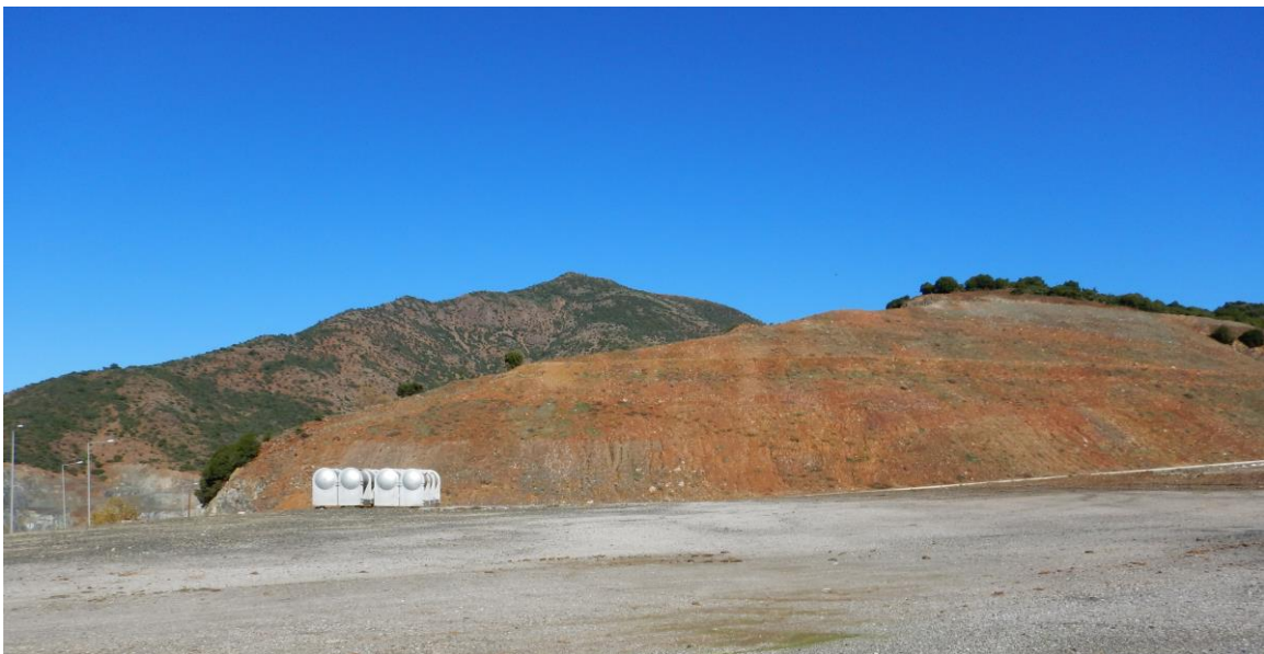
Άποψη των έργων διαμόρφωσης.
