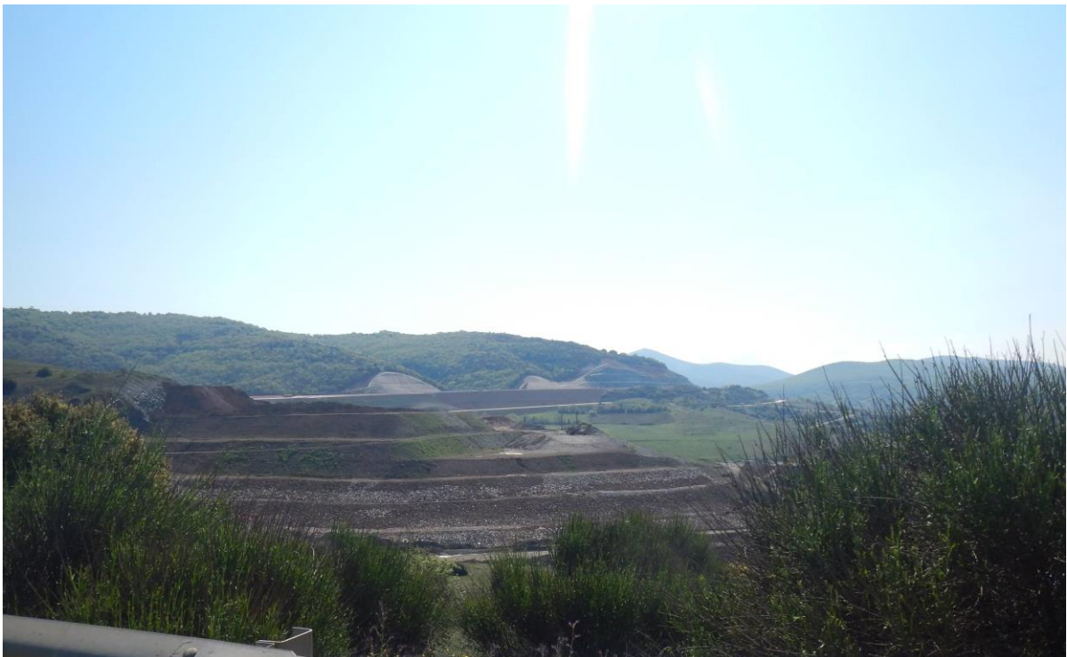
Άποψη των έργων διαμόρφωσης.
