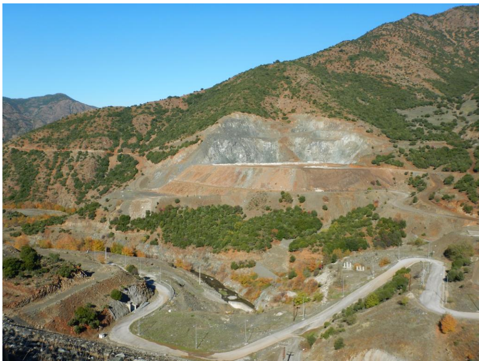
Άποψη των έργων διαμόρφωσης.
