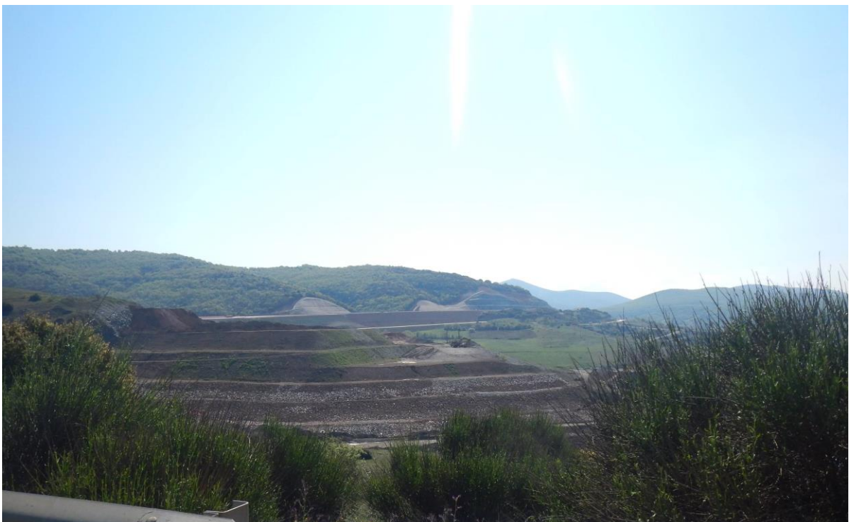
Άποψη των έργων διαμόρφωσης.
