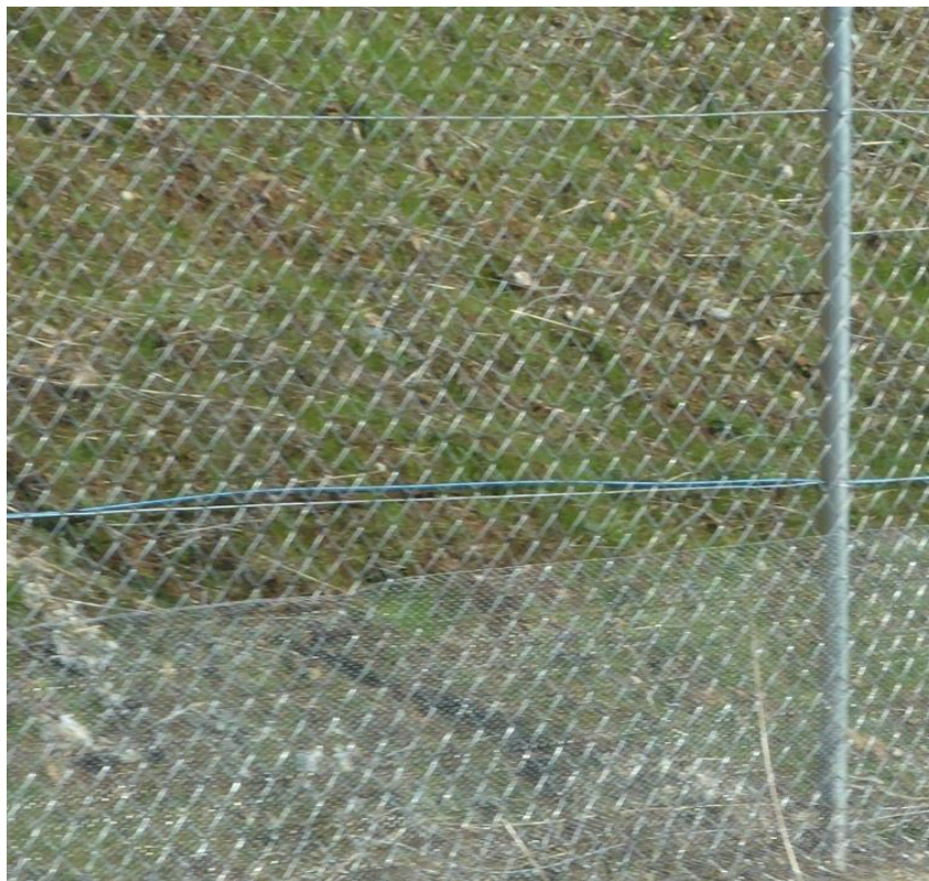
Διπλή περίφραξη διαφορετικής οπής πλέγματος για την αποτροπή εισόδου μικρόσωμων θηλαστικών εντός του αυτ/μου.
