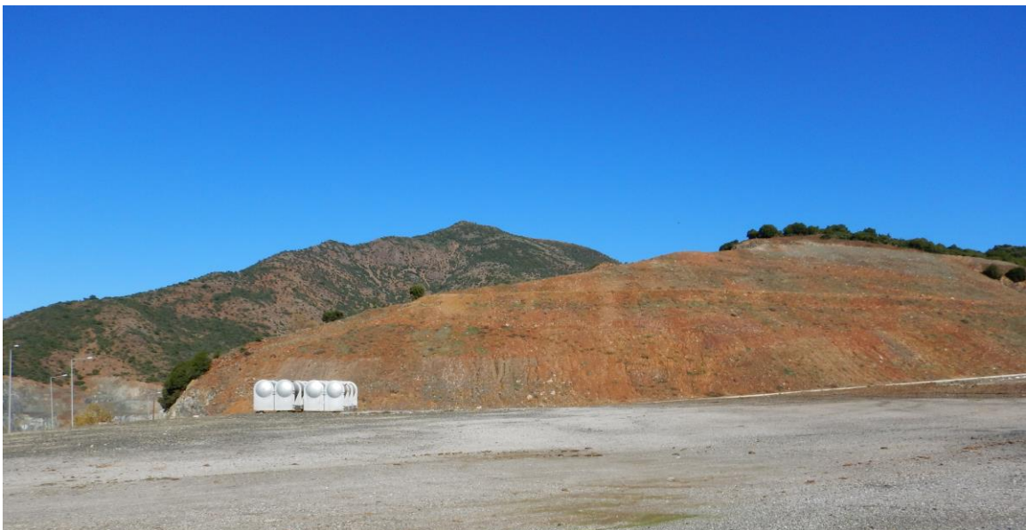
Άποψη των έργων διαμόρφωσης.
