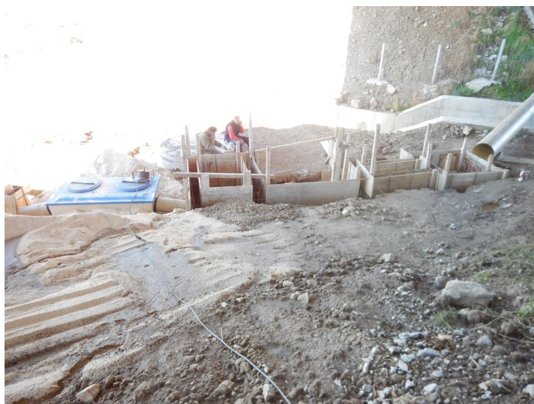
Γέφυρα π. Πηνειού. ΜΕΡ (ανάντη).
