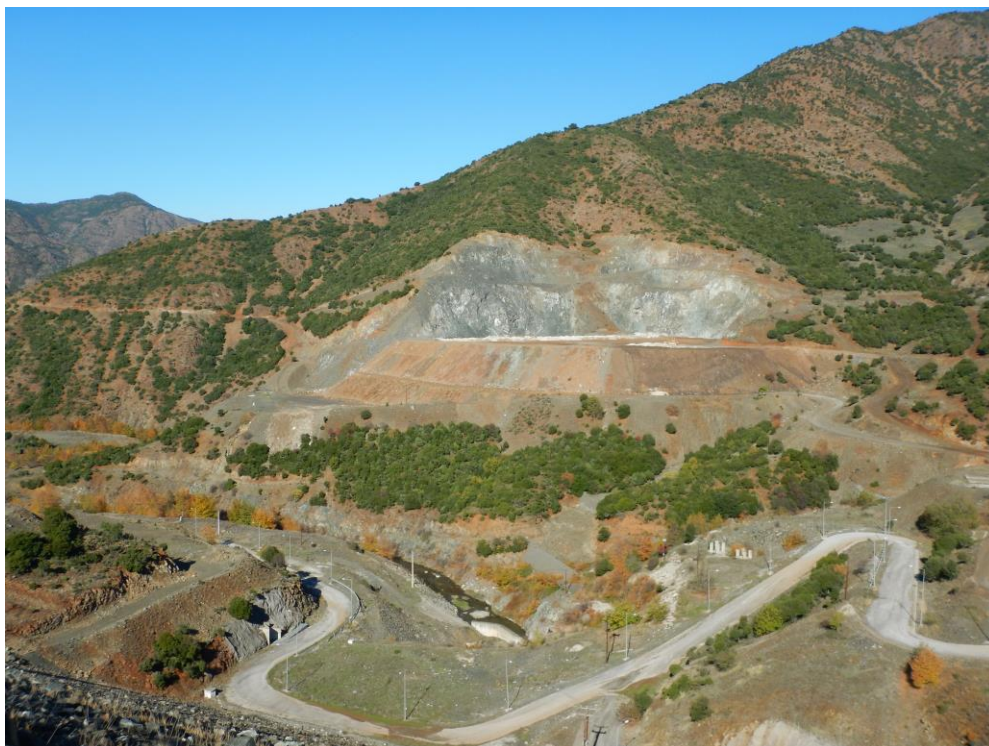
Άποψη των έργων διαμόρφωσης.
