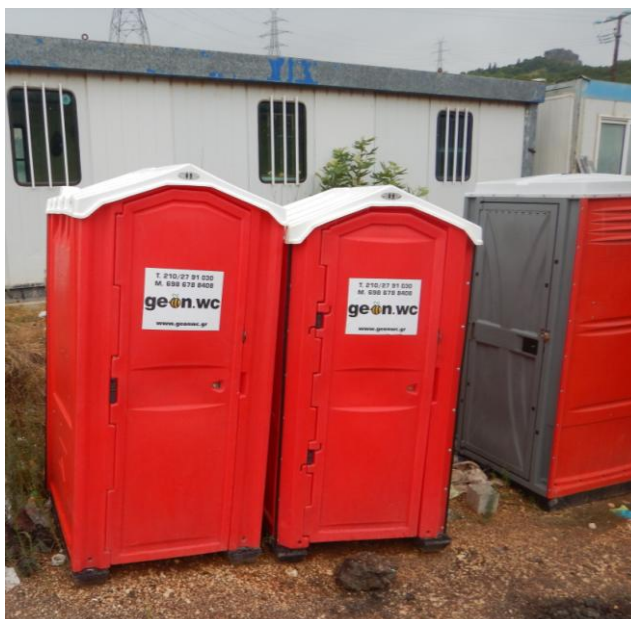
Χημικές τουαλέτες στην έξοδο της σήραγγας T2.
