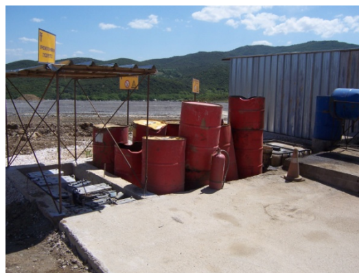
Αποθήκευση μεταχειρισμένων μπαταριών και ορυκτελαίων εντός του εργοταξίου Ανάβρας.
