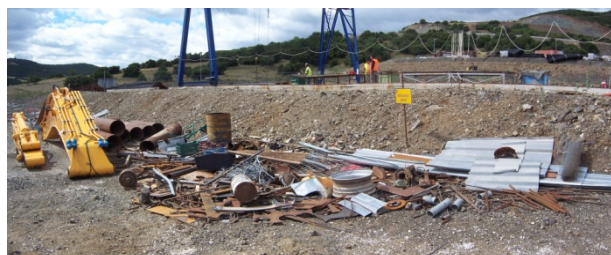
Αποθήκευση scrap εντός του εργοταξίου Ανάβρας.
