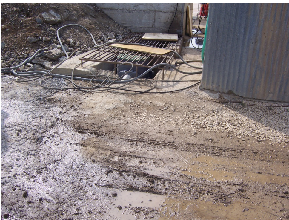
Εγκατάσταση ελαιοδιαχωριστή στο εργοτάξιο Αγ.Θεόδωροι, Ν. Καρδίτσας.
